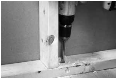
Figura N4. Preparación del agujero pasacable
