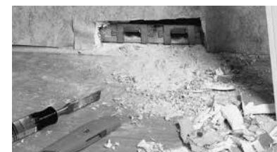
Figura R4. Limpieza del agujero pasacable
