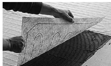
I6. Coloque la malla WTE sobre el mortero.
