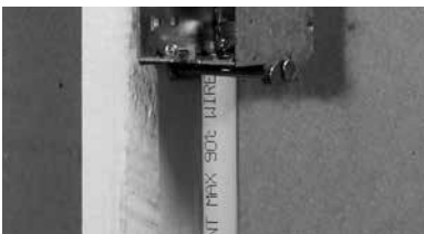
Figure N8. Installation du conduit
