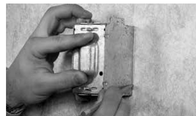
Figure R5. Marquage du contour sur le mur
