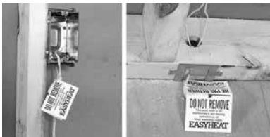
Figure N7. Installation d'étiquettes « Ne pas enlever »
