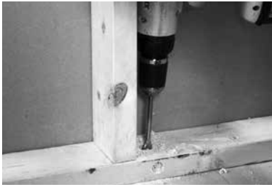
Figure N4. Préparation du trou de tirage
