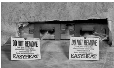
Figure R6. Installation du fil de tirage
