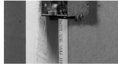
Figura N8. Instalación de conductos para cables
