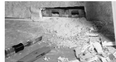
Figure R4. Nettoyage du trou de tirage
