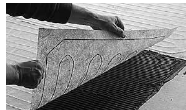
I6. Placer le treillis WTE sur le mortier
