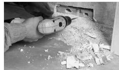
Figura R3. Preparación del agujero pasacable
