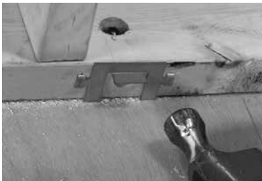
Figure N5. Installation de protège-câbles
