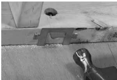
Figura N5. Instalación de los protectores
