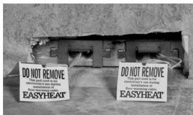
Figura R6. Inserción de la guía pasacable
